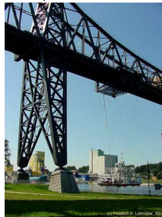
The Kiel Canal high level bridge
